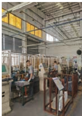
单、双弯机及冲压机等 的电气控制部分移至防 护栏外侧，大幅降低 电气控制系统于检测 维修时风险
