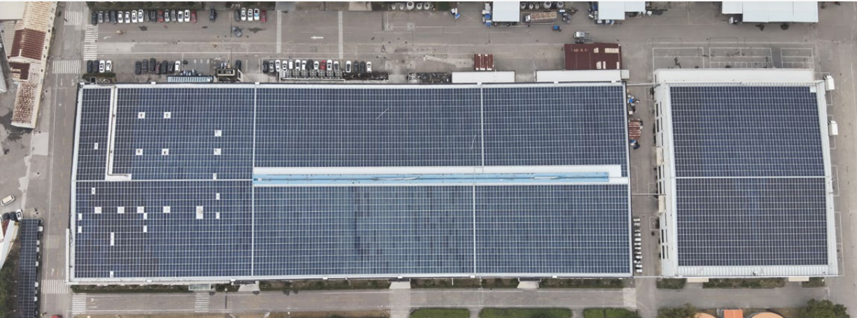
屋顶光伏铺设
